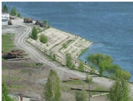
Рис. 56. Защита бетонными плитами
