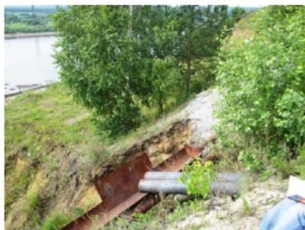
Рис. 57. Водосборные лотки
