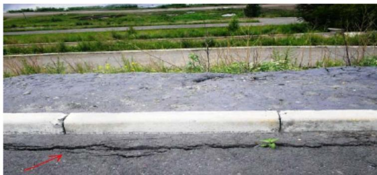
*Рис. 55. Трещина в асфальте (Лагерный сад)*
