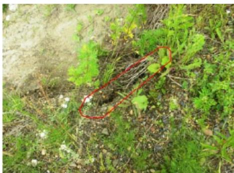
*Рис. 53. Трещина отрыва*
